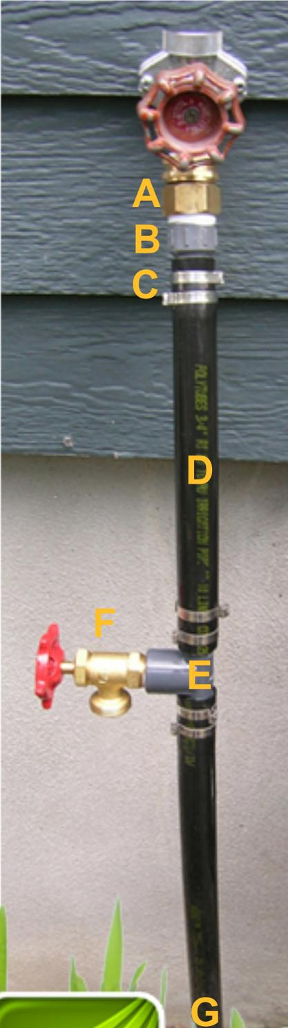
**PROJET:** Installation d'un petit système d'irrigation ayant comme source d'eau le robinet extérieur. Pour un système de plus grande envergure, il est conseillé de se relier à l'intérieur de la maison sur un tuyau de 3/4" si ce dernier est disponible.
